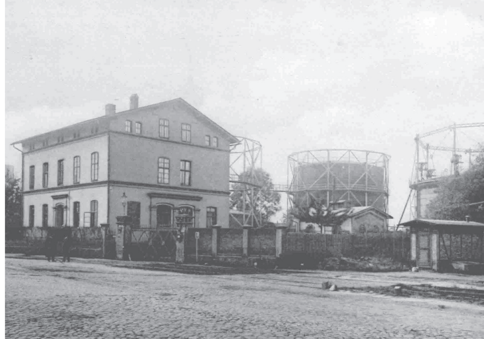
Wohn- und Verwaltungsgebäude mit Behälterstation und Kessel-/Reglerhaus nach 1897 Quelle: Stadtarchiv Halle
