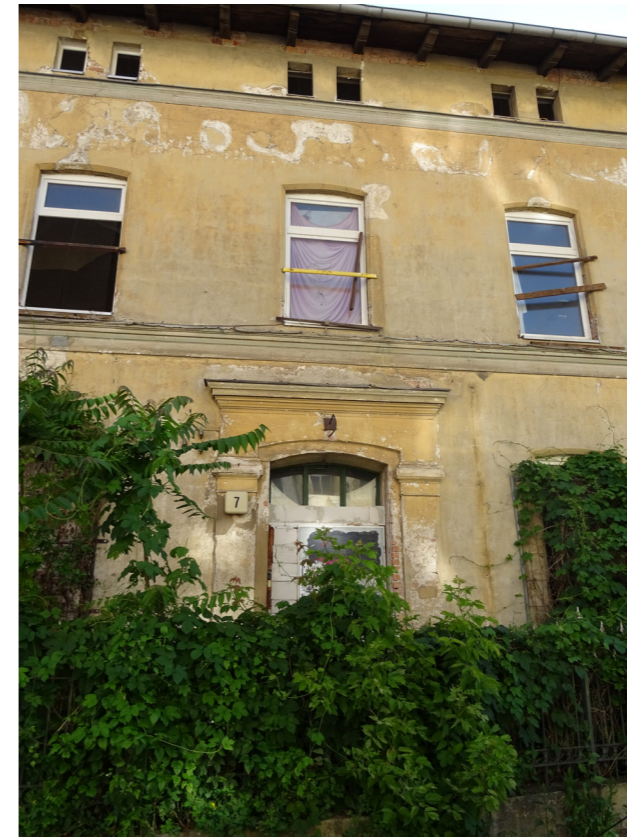
➤ Fassade zur Straße
